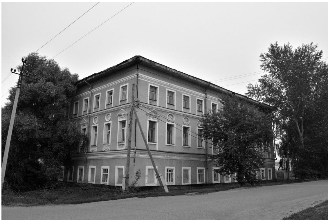
Рисунок 16. Здание по ул. Нерпинская, 48, г. Тара.
